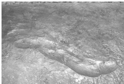
Mechanický defekt v místě anomálie
