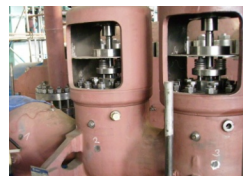
Obr. 9 Ventily s označenými místy kontroly 1,2 a 3 Fig 9 Steam valves
