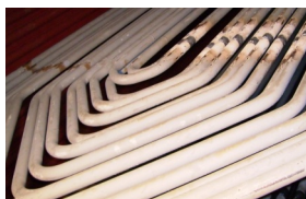
Obr. 14 Vnitřní kotlové trubky Fig. 14 Inner boiler pipes
