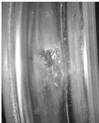
Obr. 19 Vizualně zjištěná vada Fig. 19 Visual indicated defect
