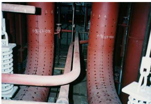
Obr. 1 Sítě tvořené jednotlivými měřícími body na ohybech potrubí
