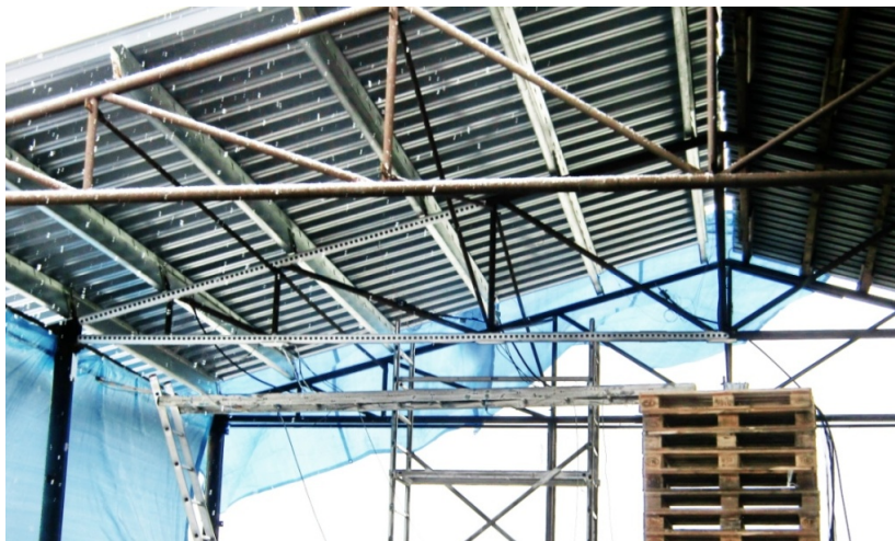
Obr. 1 Zatěžovaná část střešní konstrukce.
