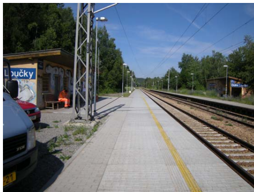
Obr. 1 Železniční stanice Dolní Loučky Fig. 1. Railway station Dolni Loucky
