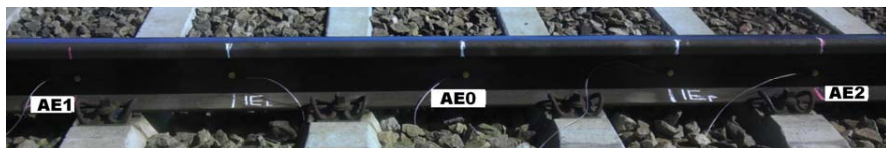
Obr. 2 Umístění snímačů AE na kolejnici Fig. 2 Location of sensors AE on the rail
