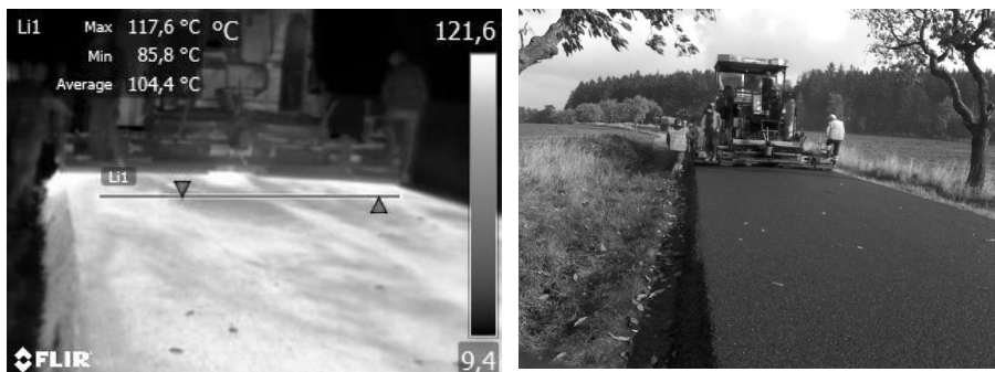
Obr. 12 Kontrola teplotní homogenity asfaltové směsi
