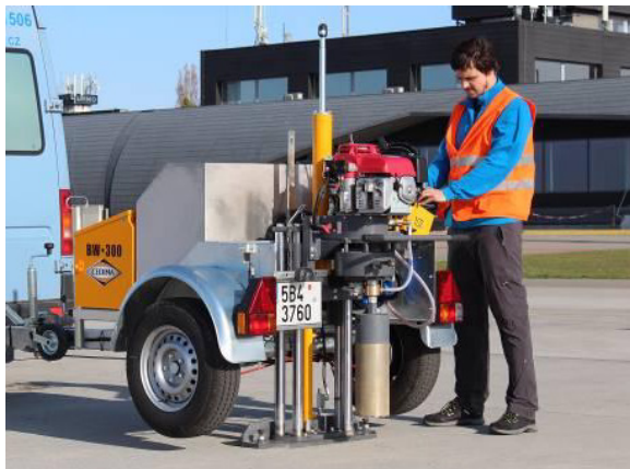
Obr. 5 Odběr jádrového vývrty, zdroj: CDV
